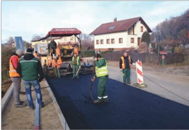
Asfaltiranje prvega dela ceste
