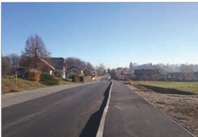
Obnovljena cesta in pločnik že kažeta na novo podobo.
